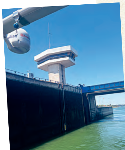
Die Rheinschleuse Iffezheim.
